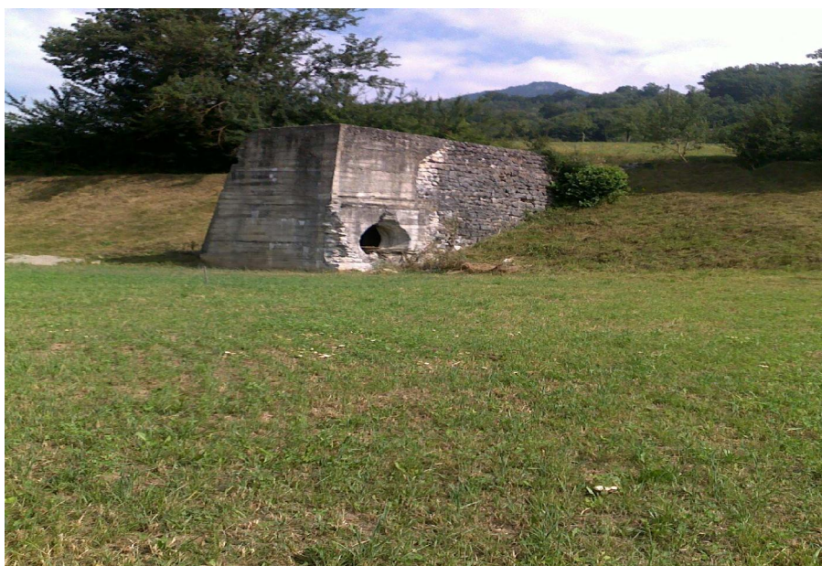
Slika broj 2: Ostaci hidrocentrale u selu Bistrica
