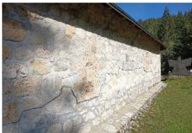
Slika 65. Zid crkve sa označeno linijom obnovljenog dijela
