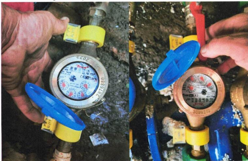
Slika: Fotografija sa terena prilikom zamjene i plombiranja vodomjera
