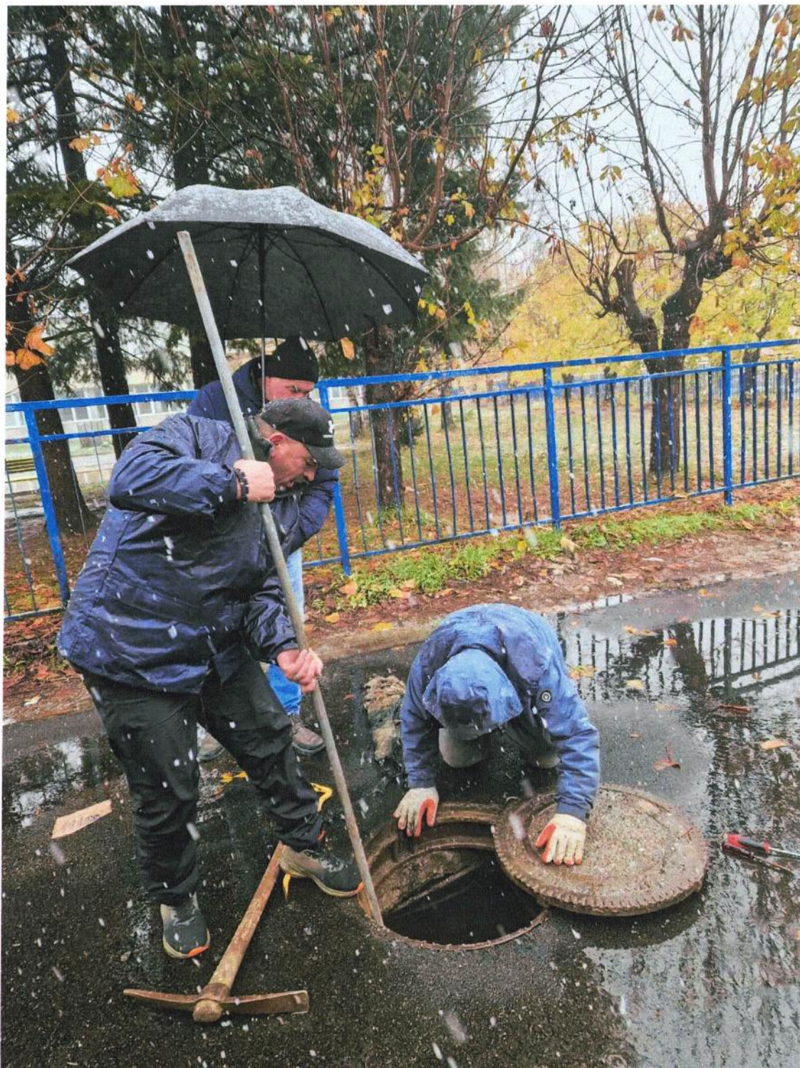
Slika: Rad radnika na otčepljenju fekalne kanalizacije pored objekta OŠ Marko Miljanov u ul. Iva Andrića
