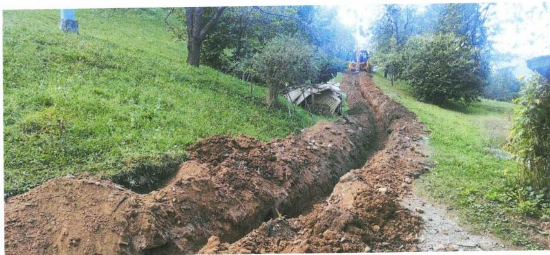
Slika: Izrada vodovodnih priključaka za grupu potrošača u mjestu Ribarevine
