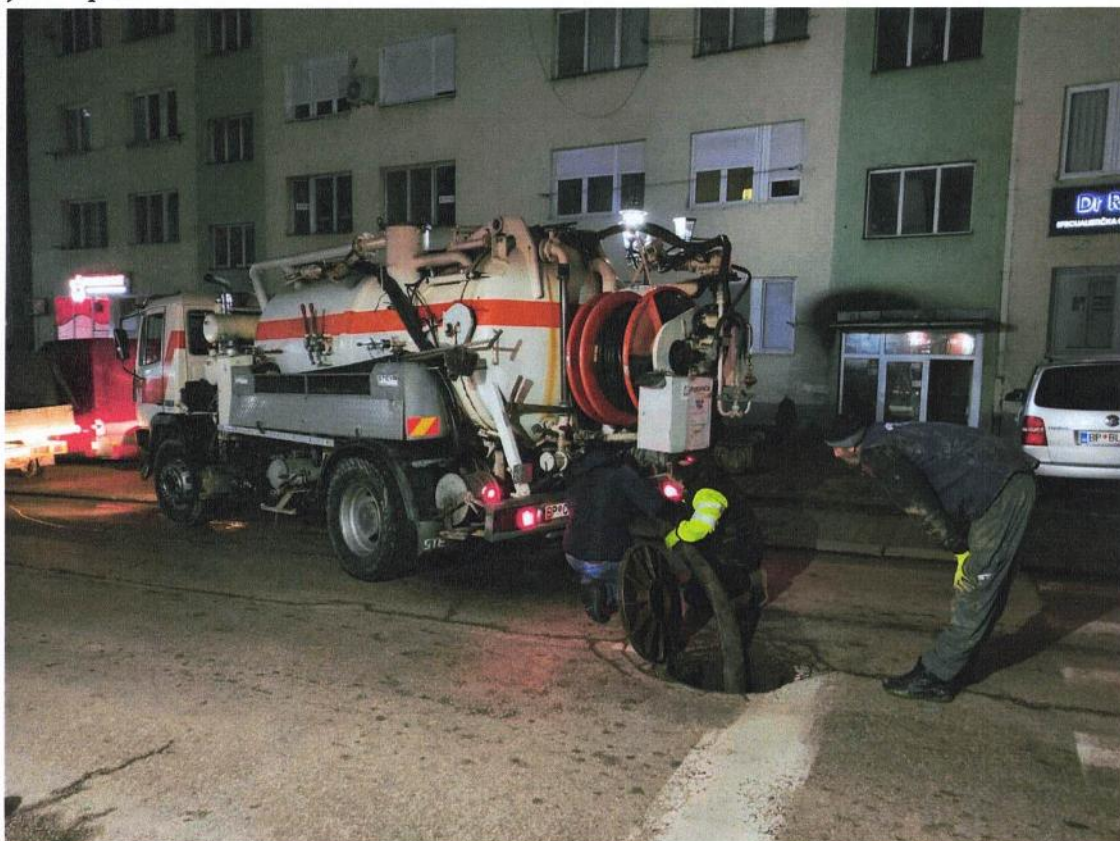
Slika: Steyr cistjerna za odgušenje i crpljenje kanalizacije, prilikom odgušenja kanalizacije u centru grada – mjesto ul. R. Burdžovića Trša (Sjениčka zgrada)
