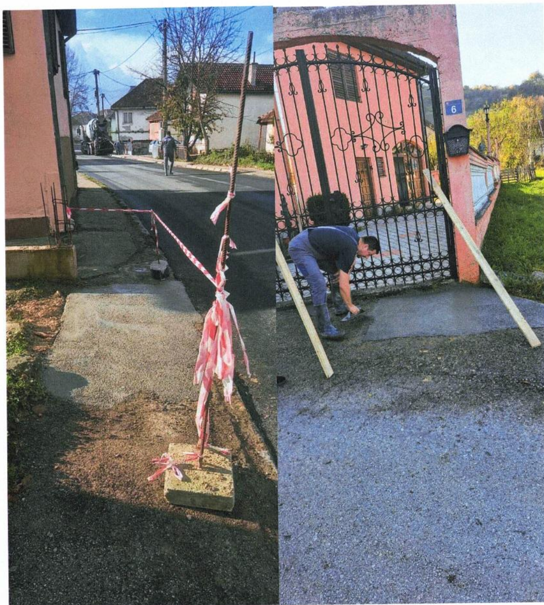
Slike: Betoniranje na mjestima gdje je otklonjen kvar na vodovodnoj mreži u ul. III Sandžacke brigade i u naselju Rasovo
