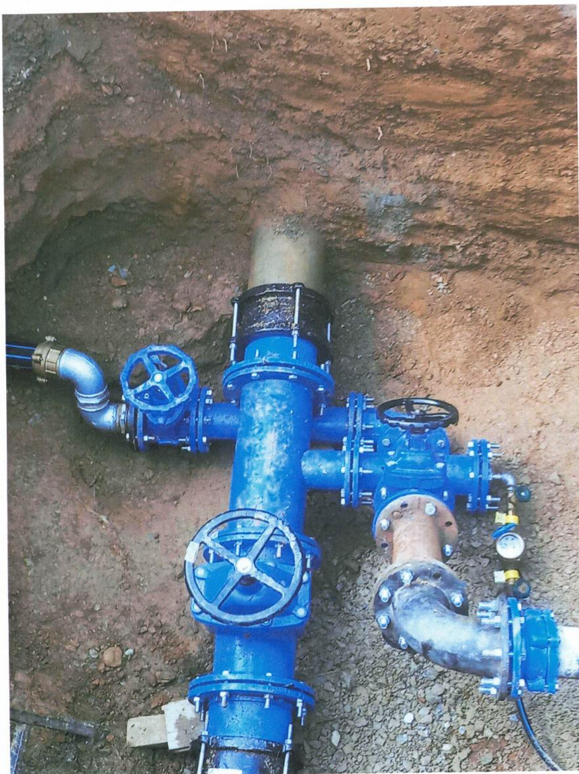
Slika: Izrada vodovodnog priključka za potrebe OŠ „Dušan Korać“ u ul. Voja Lješnjaka
