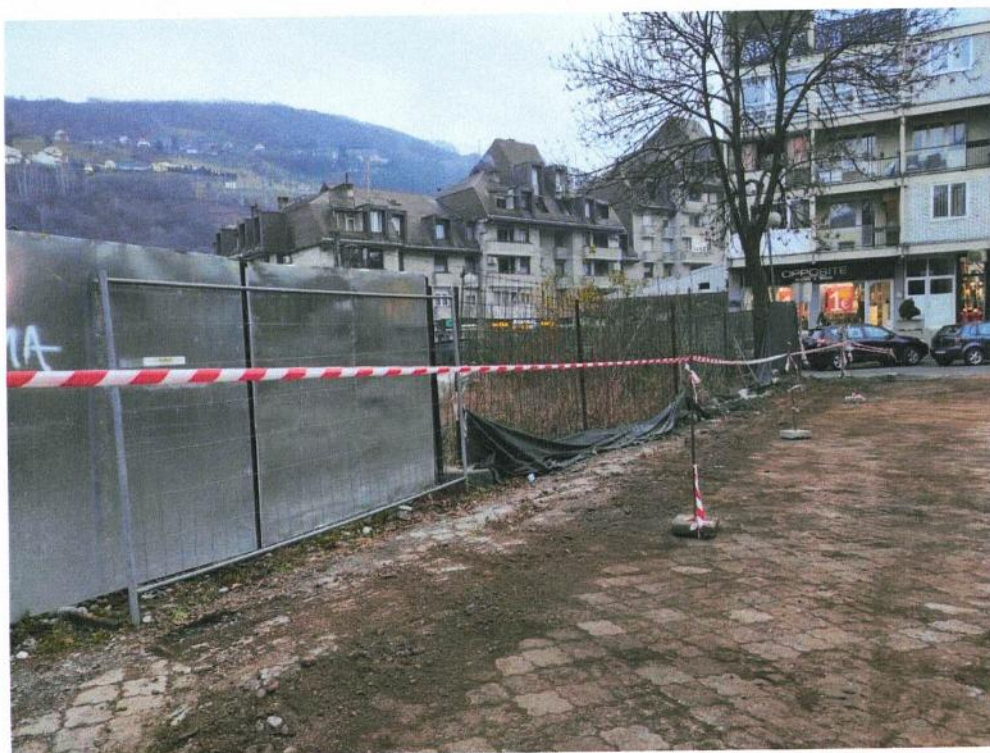
Slike: Izvođenje radova na priključenju poslovno stambenog objekta u ul. Rifata Burdžovića Trša na gradsku vodovodnu mrežu ACC DN 100mm.
