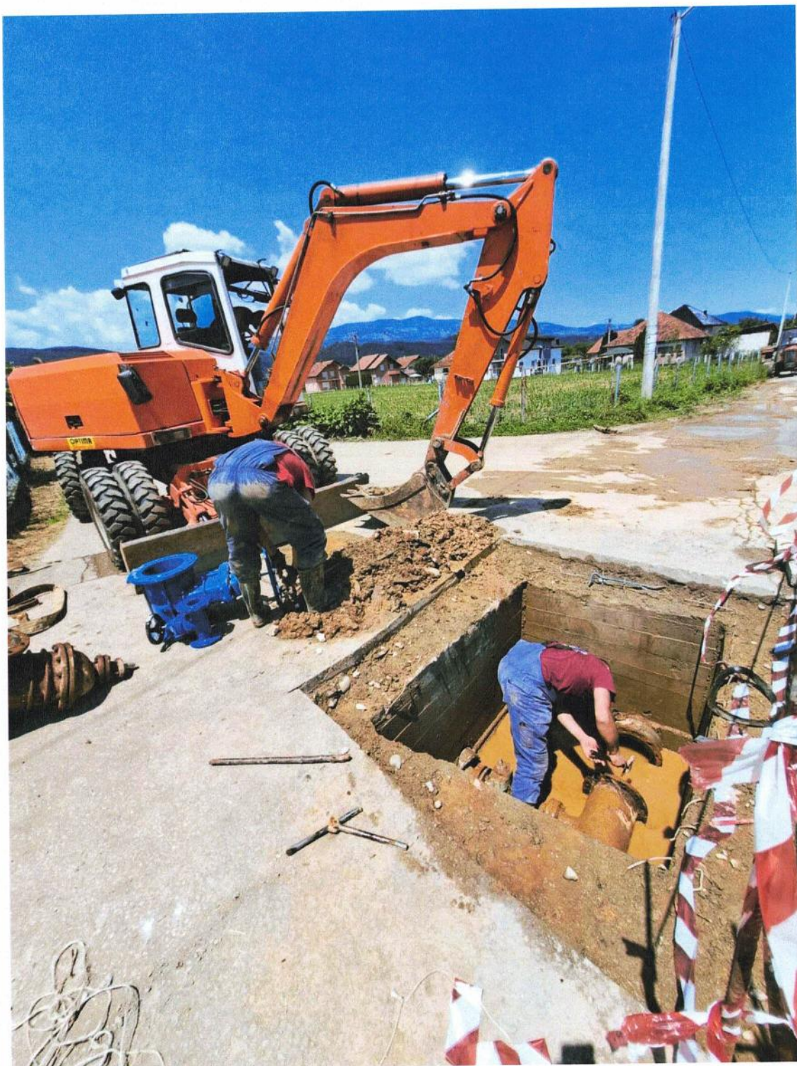
Slika: Zamjena starih ventila i ugradnja novih na glavnom distributivnom cjevovodu PVC 250mm kroz mjesto Rasovo sa izradom armirano betonske ploče i metalnog poklopca za teški saobraćaj
