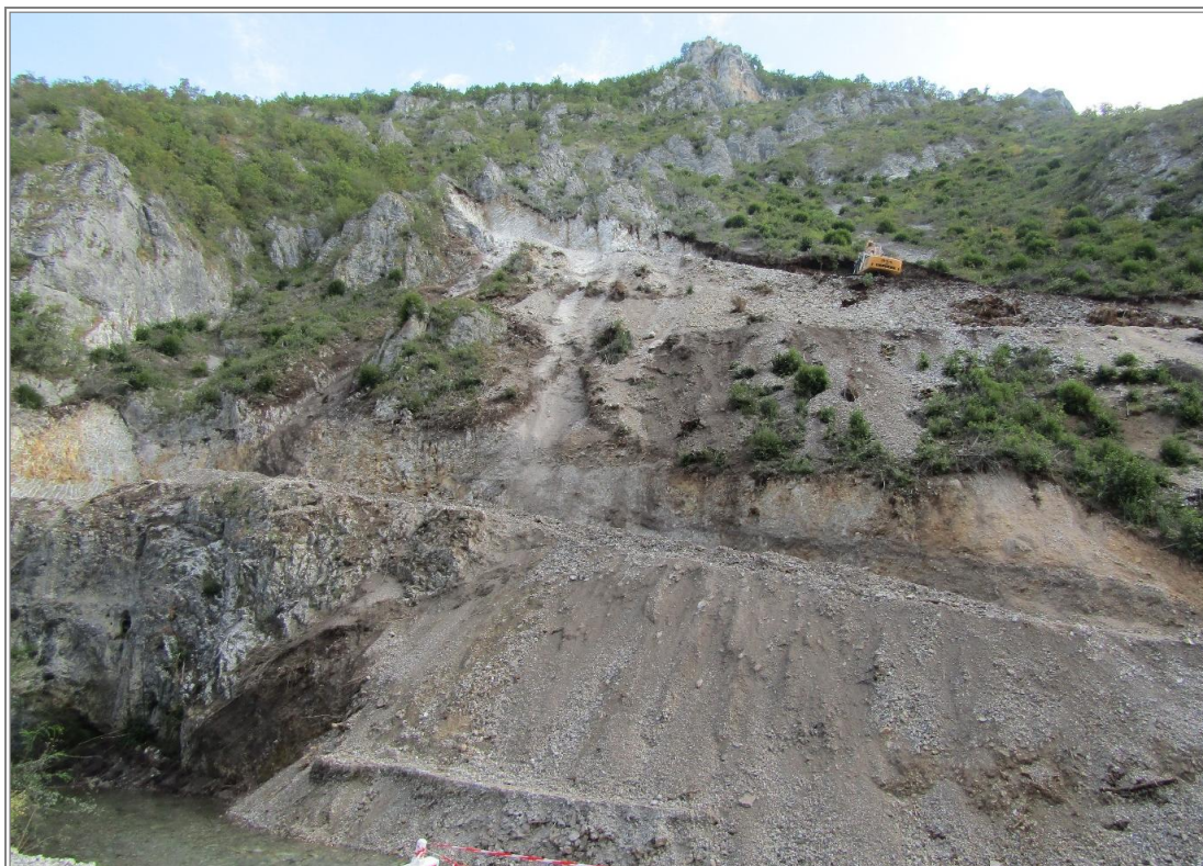
Slika 2. Izgled ležišta tehničko-građevinskog kamena „Bioča“
