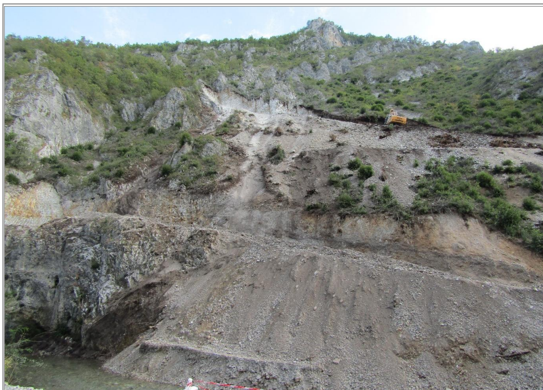
Slika 2. Izgled ležišta tehničko-građevinskog kamena „Bioča“
