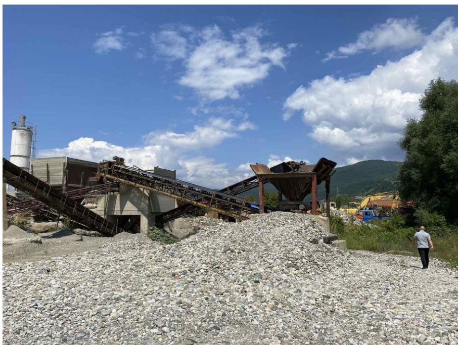
Slika 7. Postrojenje za separaciju šljunka i pijeska, avgust 2023.
