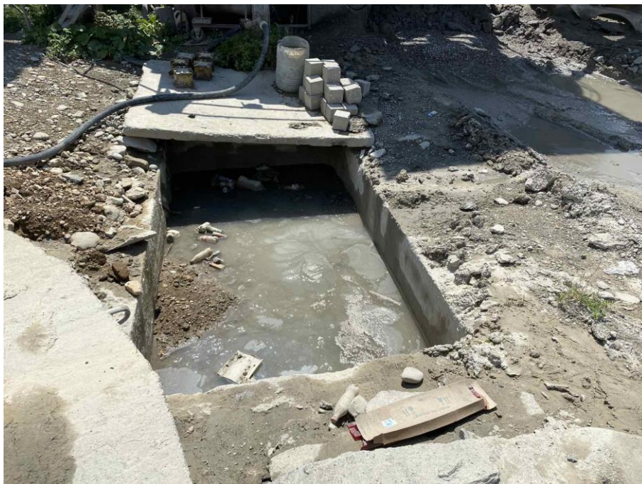
Slika 6. Taložnik-objekat za proizvodnju betona, avgust 2023.godine
