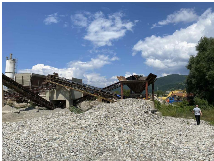
Slika 8. Postrojenje za separaciju šljunka i pijeska, avgust 2023.
