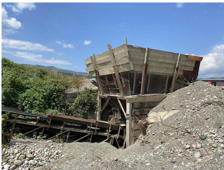
Slika 9. Postrojenje za separaciju šljunka i pijeska, avgust 2023.
