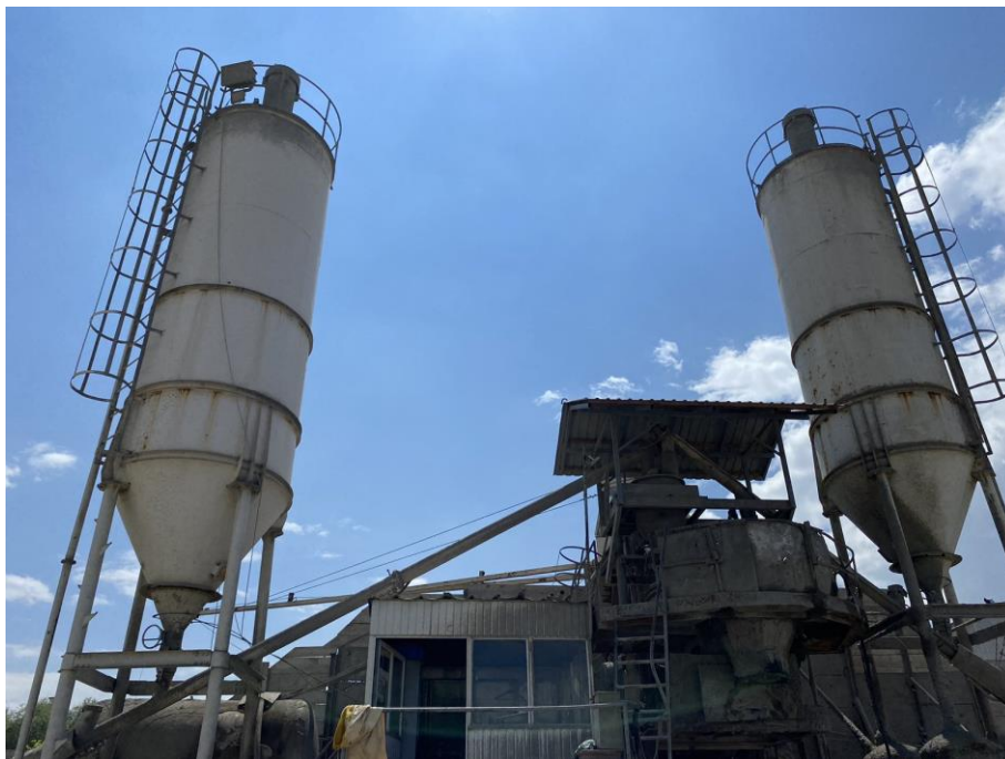
Sl23. Silosi za cement i objekat za proizvodnju betona, avgust 2023.
