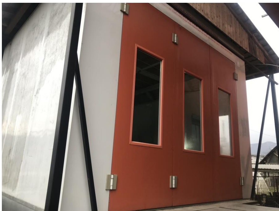
Slika 8. Spoljašnjost objekta- ulazna vrata komore, mart 2022.
