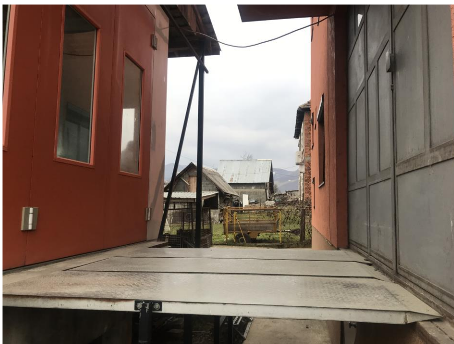
Slika 9. Spoljašnjost objekta- ulazna vrata komore, mart 2022.
