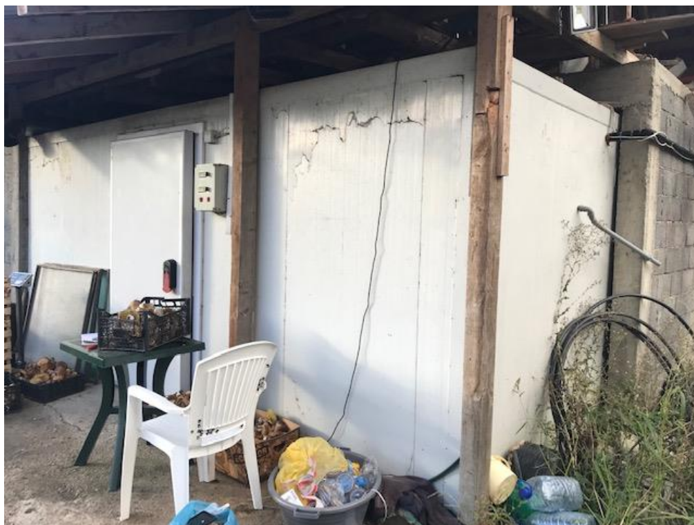
Slika 9. Spoljašnjost objekta- ulazna vrata komore, septembar 2022.
