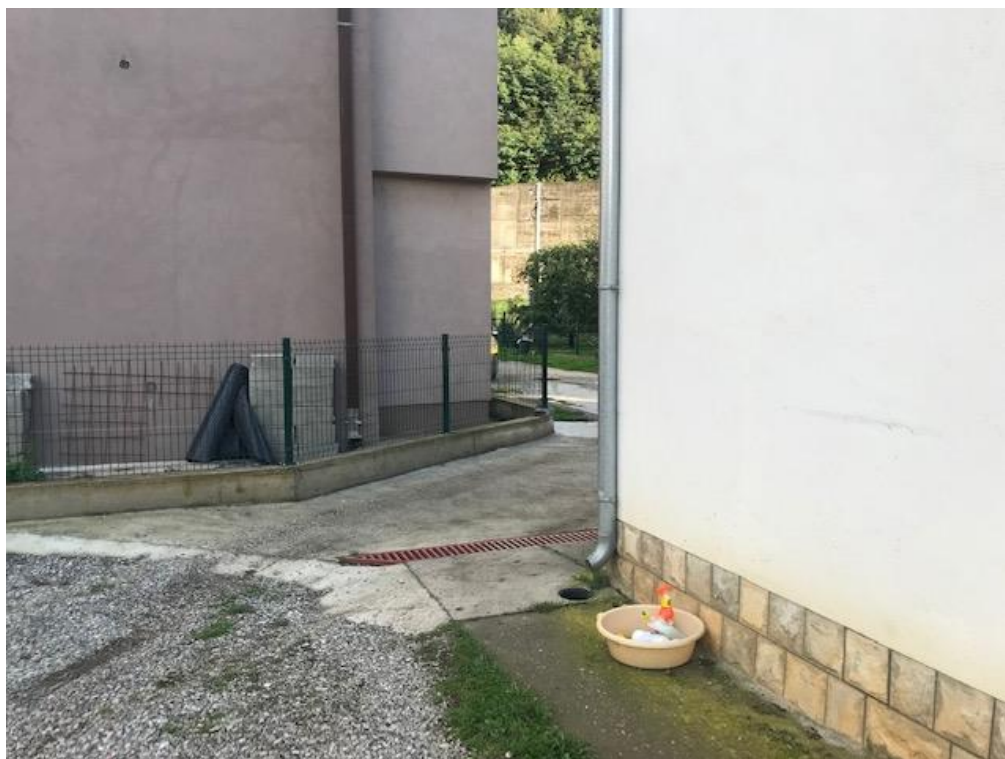
Slika 11. Putni prilaz objektu u kom je smještena predmetna sušara u komora, septembar 2022.
