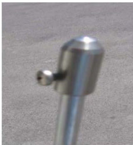
Slika 4: Izgled špica LOV montiranog na vodič Fe/Zn Ø8 mm
