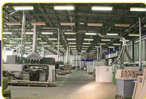
Sl.26a. Sistem za otprašivanje i odvod strugotine nastale radom u pogonu
