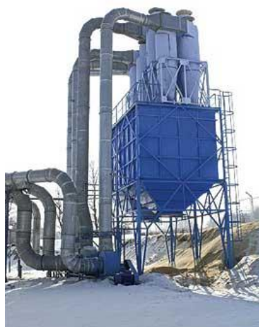
Sl.26 b. Silos za pilotinu iz sistema za otprašivanje predmetnog pogona
