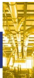
Sl.26a. Sistem za otprašivanje i odvod strugotine nastale radom u pogonu
