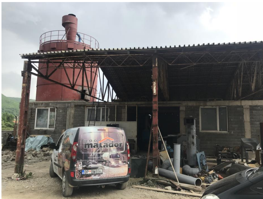
Slika 5. Izgled predmetnog objekta i lokacije sa njenim okruženjem, jun 2021.godine
