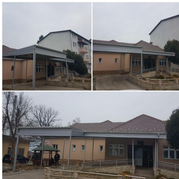
Slika 4. Rekonstrukcija krova i nadstrešnice
